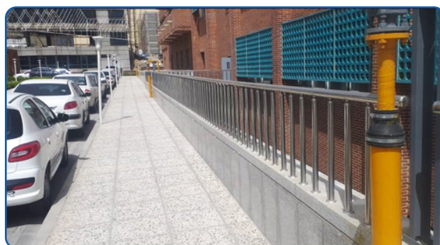
نصب نرده به منظور پیشگیری از سقوط افراد
